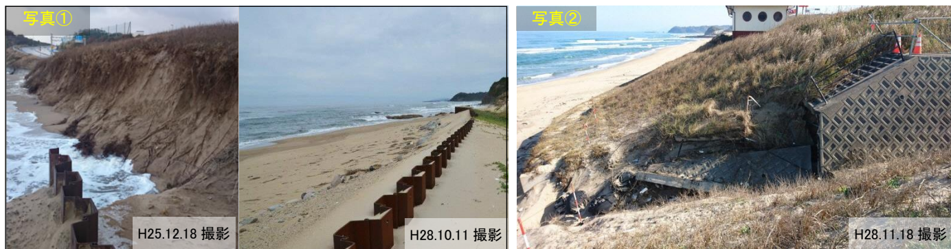
図 9.1.1 現地写真(被災状況・復旧状況)
